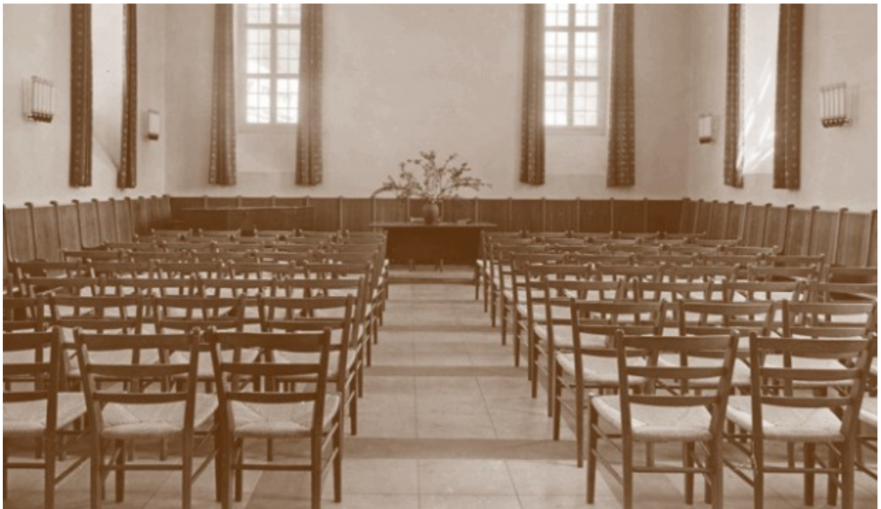
Alte Kirche Fluntern, 8044 Zürich (ca. 1950)
